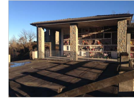
Rimozione e nuova posa di guaina bituminosa impermeabilizzante
