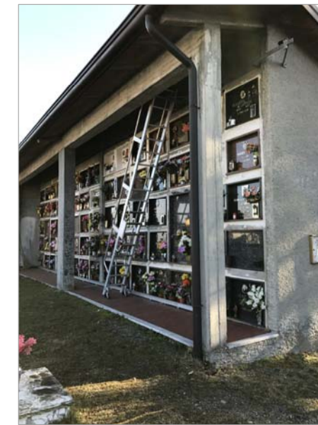
Realizzazione di fognatura mancante per il deflusso delle acque meteoriche
