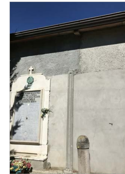
Tamponatura della facciata frontale mediante intonaco armato
