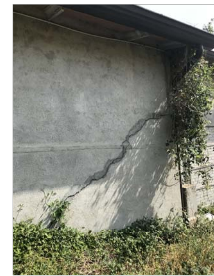
Ripristino di lesione con rete in F.R.P. (GeoSteel Grid 200 e Geocotex)
