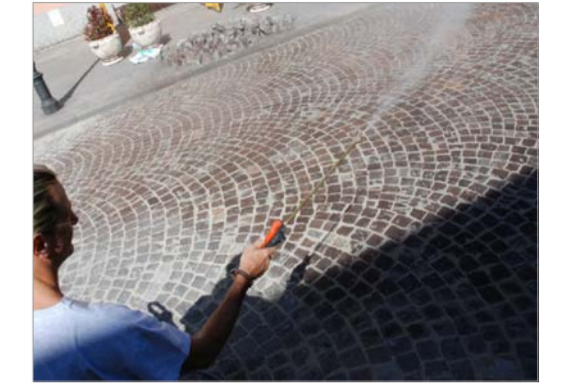
Terminato il riempimento dei giunti della pavimentazione con SABBIAFIX, si procede alla sua attivazione mediante nebulizzazione in modo tale che indurisca all'interno delle fughe.
