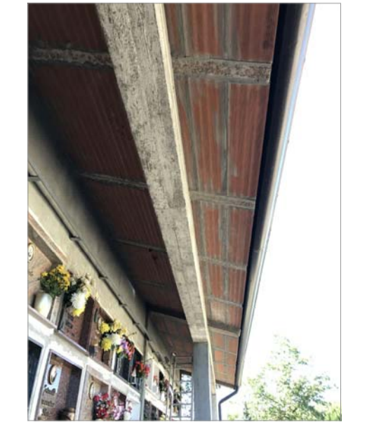
Realizzazione di nuovo intonaco sottotetto e tinteggio
