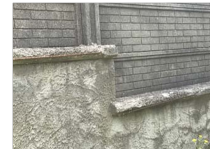
Ripristino delle copertine ammalorate con geomatta txotropica (Geolite)
