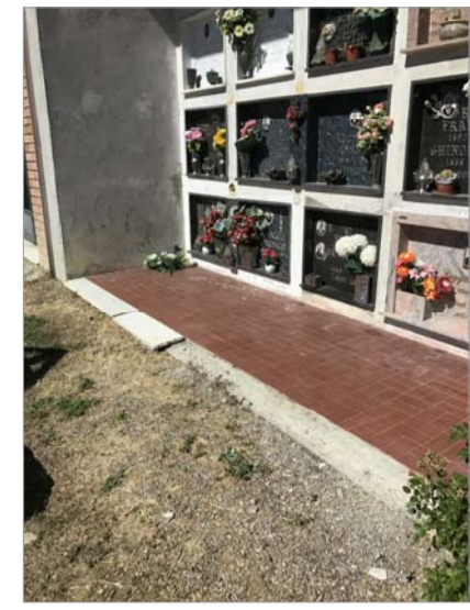
Rifacimento marciapiede settore loculi n°1,2,3 (Ditta Salmè, Serie Cosmos)
