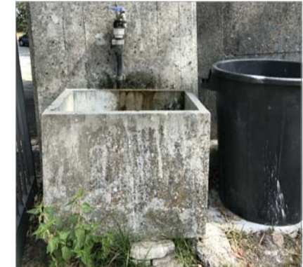
Installazione di lavabo prefabbricato in cemento (Ditta EMIC mod. FOR4P)
