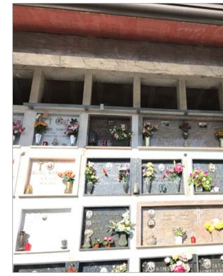
Tamponamento ultima fila di loculi, intonaco e tinteggio
