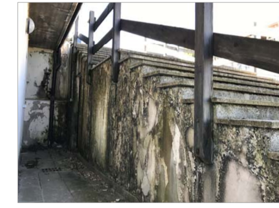
Rifacimento intonaco ammalorato scala e sostituzione del parapetto
