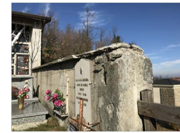
Consolidamento muro mediante intonaco armato e rifacimento in opera della copertina in c.a.
