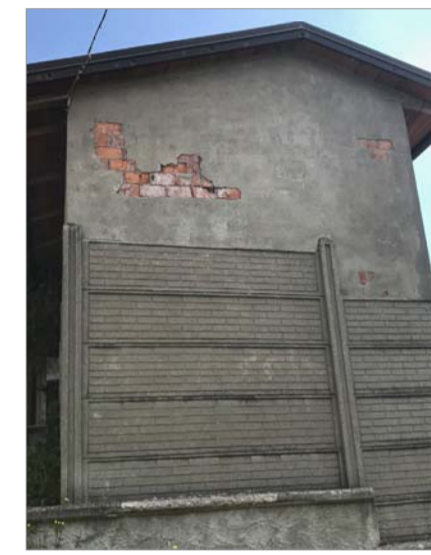
Ripristino intonaco settore loculi n°1
