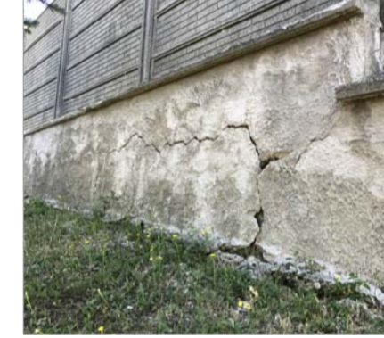
Spolconatura di intonaco esistente ammalorato e rifacimento nuovo intonaco armato
