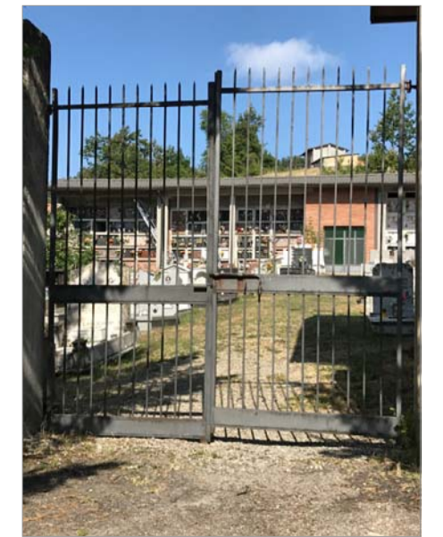
Rifacimento cancello metallico d'accesso
