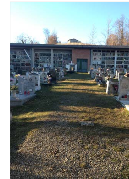
Realizzazione di vialetto pedonale
