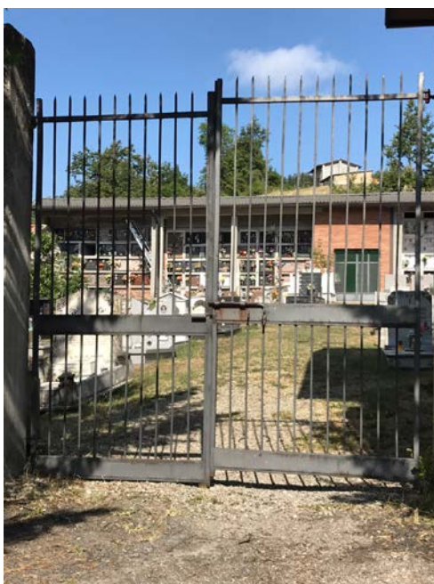
Figura 10 – Cancello metallico d'accesso
