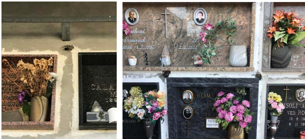
Figura 20 – Impianto elettrico esistente
