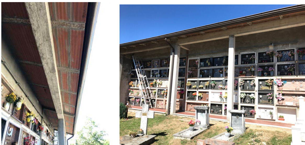
Figura 9 – Sottotetto grezzo settore loculi n°1, 2 e 3
