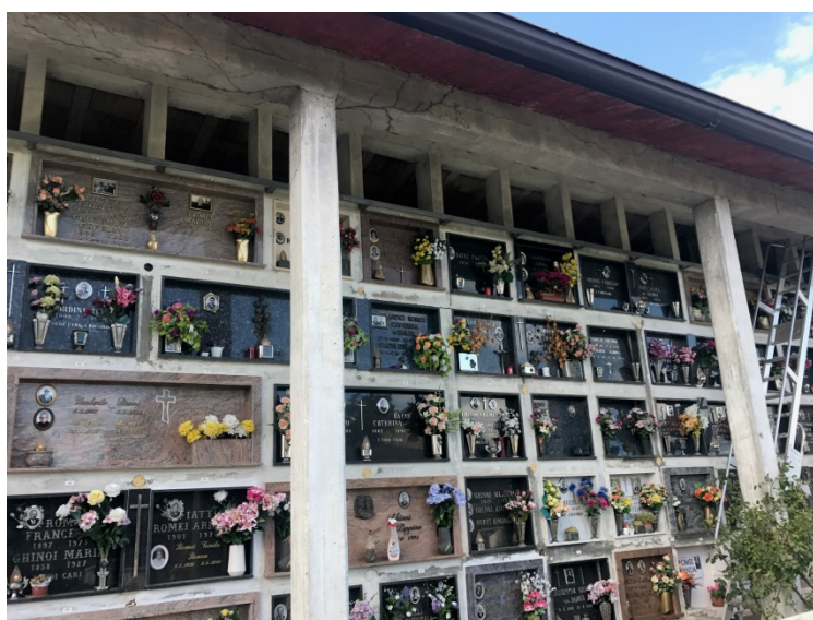
Figura 18 – Fila di loculi da tamponare
