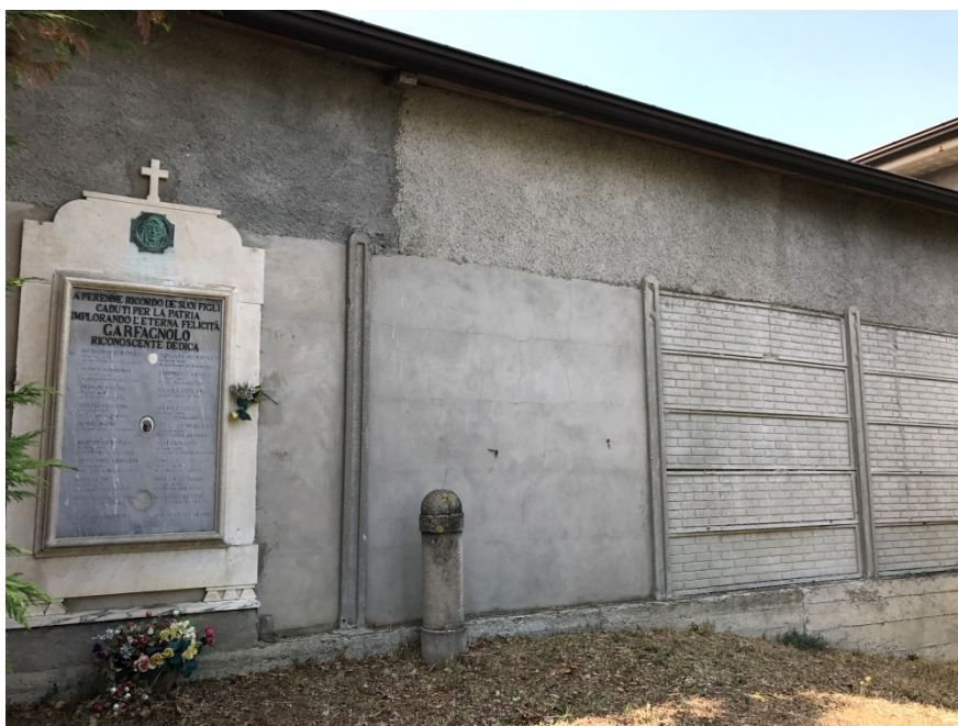
Figura 8 - Manutenzione facciata con pannelli in fibro-cemento
